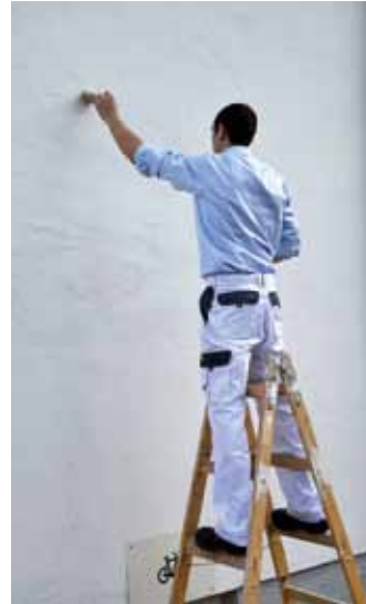
RICHTIG Wählen Sie der Arbeitshöhe entsprechende Hilfsmittel (Leitern) aus. Stehleitern dürfen nur freistehend benutzt werden.
