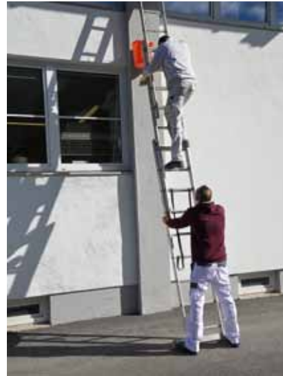
RICHTIG Sichern Sie Anlegeleitern gegen Abrutschen durch Befestigung oder eine zweite Person.
