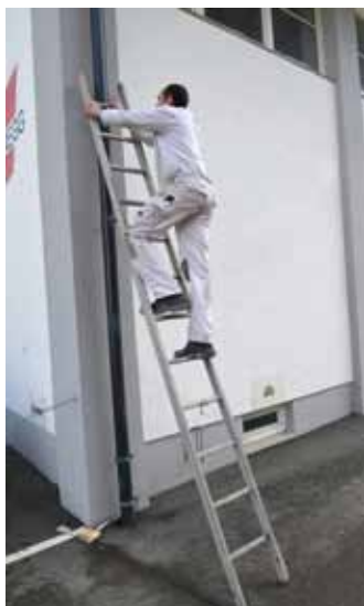
FALSCH Lehnen Sie Leitern nicht an Mauer-ecken, Masten etc. an.
