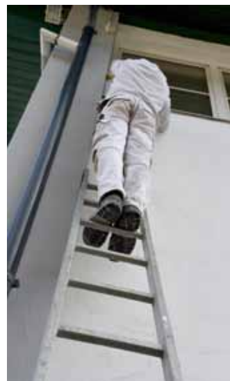
RICHTIG Leitern dürfen nur auf waagrecht, rutschsicherem und festem Untergrund (keinesfalls Folien, Sand, Styropor etc.) aufgestellt werden. Der Anstellwinkel soll etwa 70° betragen.
