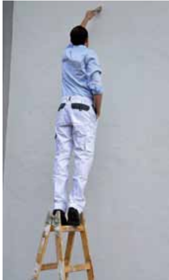
FALSCH Bei beidseitig begehbaren Stehleitern ist die letzte Sprosse oder oberste Stufe nicht zu betreten.
