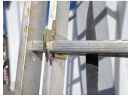
RICHTIG Die Leiter wurde ordnungsgemäß gesichert.
